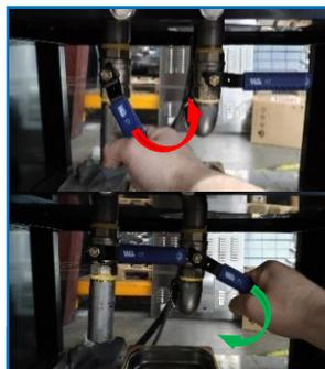
4. Une fois le nettoyage à la douche terminé, fermer la vanne "Graisses" puis ouvrir la vanne "Nettoyage".
